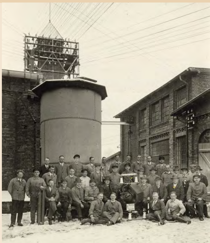
Elektrische Zentrale mit Stromleitungen
